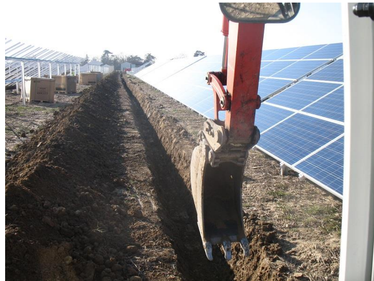
Photographie 73. Exemple de tranchée entre deux tables photovoltaïques
