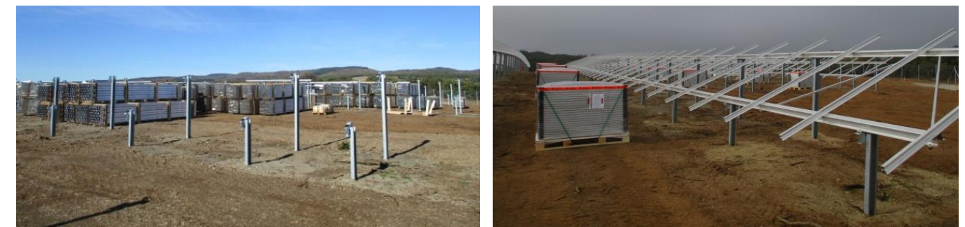
Photographie 71. Assemblage des structures sur site
