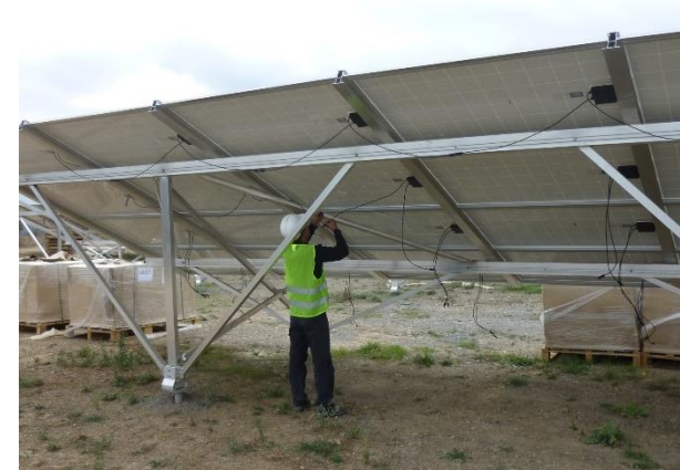
Photographie 75. À gauche : Câblage des panneaux – À droite : Boîtier de raccordement
