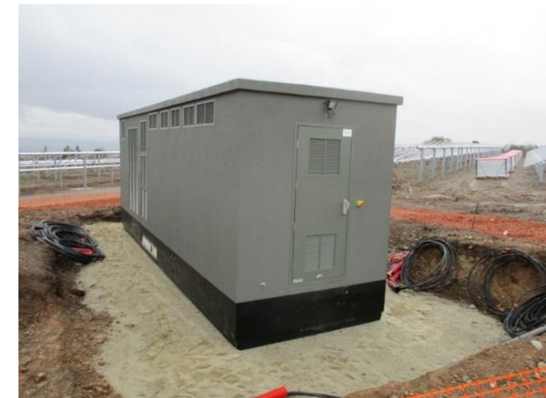
Photographie 74. Installation d'un poste électrique
