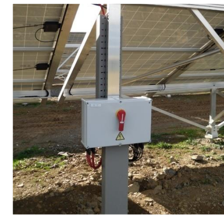
Photographie 75. À gauche : Câblage des panneaux – À droite : Boîtier de raccordement
